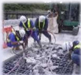
▲修繕・耐震補強
